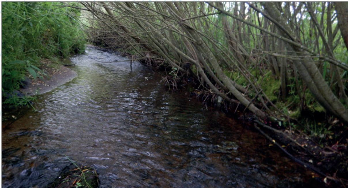
Obr. 200a. Celkový pohled od hladiny Zbytinského potoka na nejdelší oživený haťošterkový válec po deseti letech.
