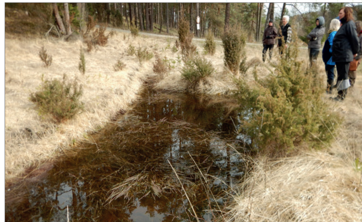
Obr. 164a. Vsakovací tůň pod zářezem cesty přes PR Miletínky. Boční tůň v povodí Zlatého potoka s kombinovanou funkcí, budována jako experimentální – modelový objekt, na kterém měly být ověřovány očekávané funkce. Tůň bezprostředně po vyhloubení v roce 2010.
