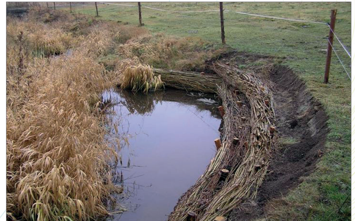
Obr. 198a. Realizace většího množství oživených haťošterkových válců podle projektu Vejmelkové a Šimona (2006) realizoval v listopadu 2006 správce toku ZVHS Prachatice (dnes podnik Povodí Vltavy).
