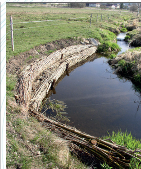
Obr. 151c. Metrová postupující eroze stabilizovaná haťošterkovým oživeným válcem v listopadu 2006 (více fotografií viz Příloha 23).
