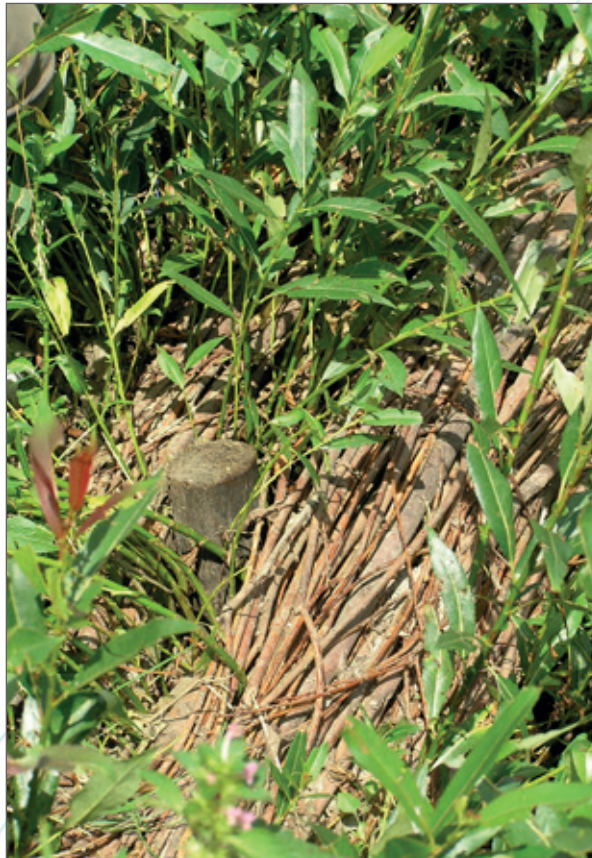
Obr. 199a. Detail oživeného haťošterkového válce po jedné vegetační sezóně v roce 2007 (upevňovací kůl ze smrkové kulatiny, svazky proutí svázané páleným drátem silně obráží a zespoda prokořeňují).
