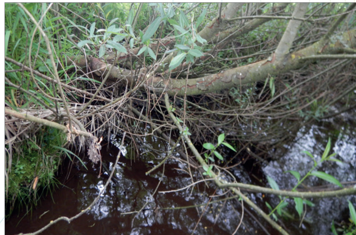
Obr. 153a. Příklad haťošterkových válců vyžadujících údržbu. Vyvrácené kmínky, zasahující do průtočného profilu, je nutno vyřezat.
