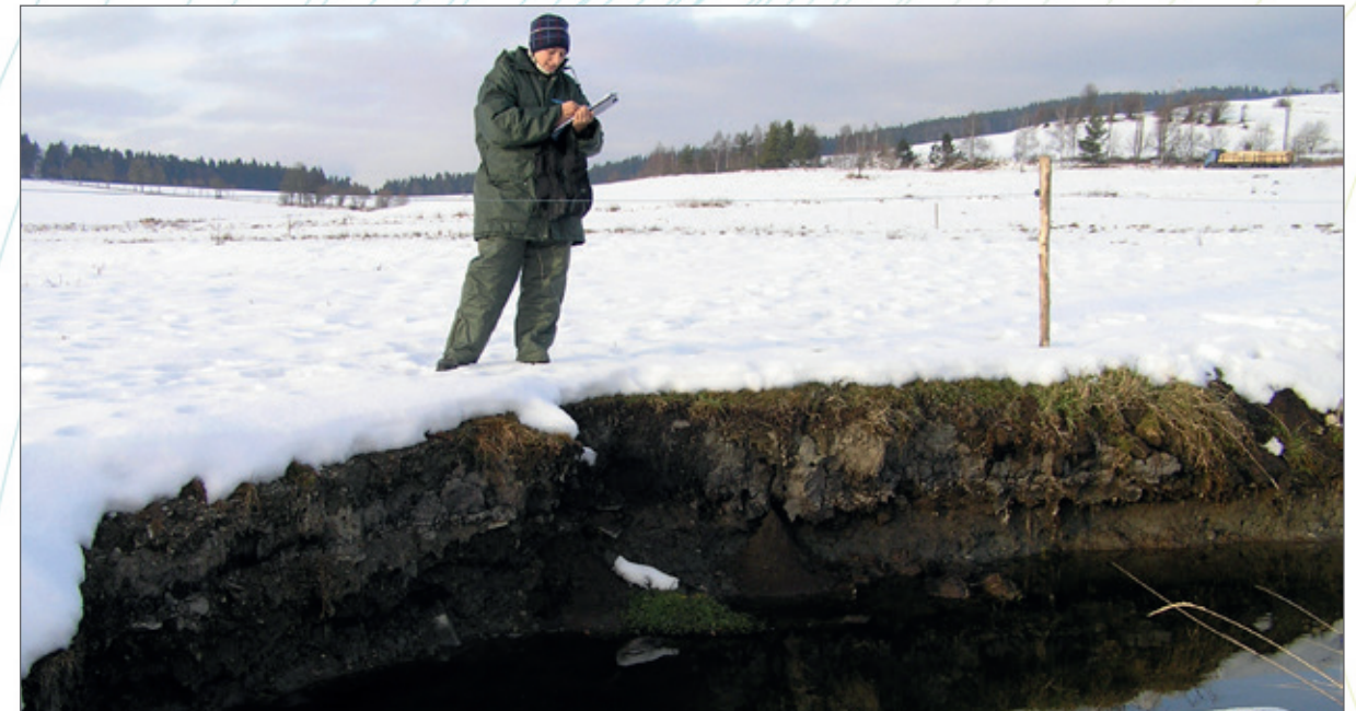
Obr. 196. Stav ohybu „D-a“ v prosinci 2005, kdy již byly zaznamenány masivní vnosy písku do hlavního toku Blanice. Jako řešení byly navrženy haťošterkové oživené válce.
