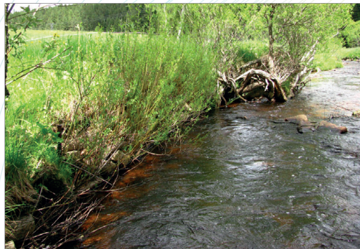
Obr. 154b. Celkový pohled na obrostlou srubovou konstrukci z vrb po jedné vegetační sezóně.
