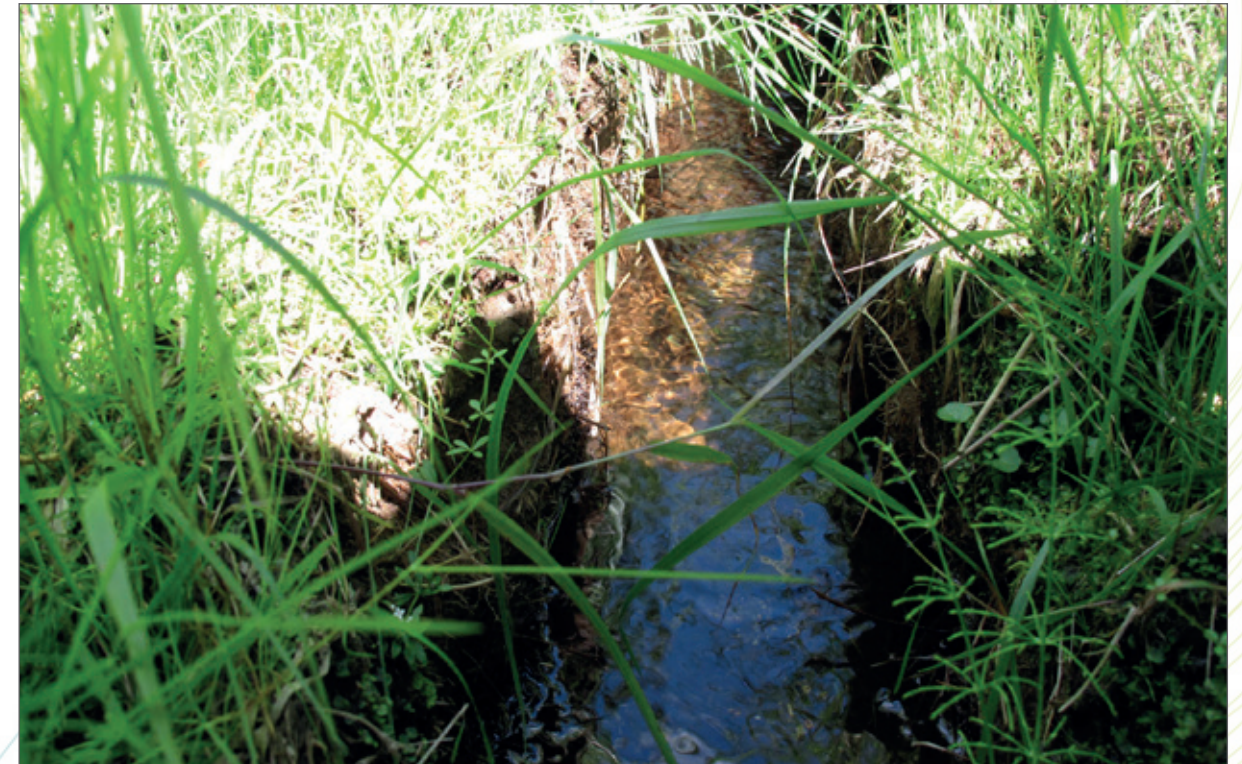
Obr. 162a. Vzhled potravní stružky. Potravní stružky je potřeba pravidelně kontrolovat a vždy po několika letech obnovovat na původní šířku, protože se postupně zanášejí a zarůstají. Pročištěná potravní stružka v povodí Lužního potoka.
