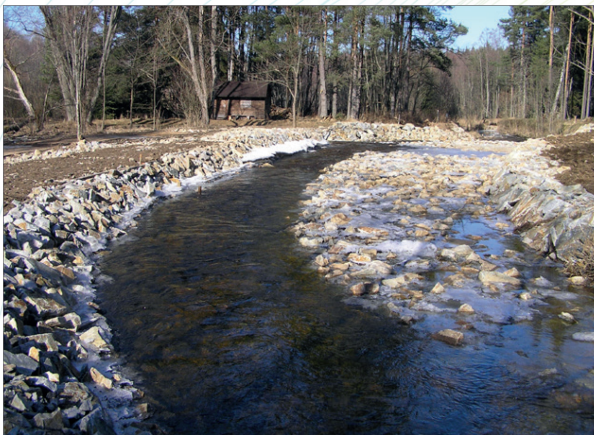
Obr. 155. Opevnění meandru z lomového kamene, provedené při nutné stabilizaci břehu nad příčným stupněm zavodňujícím boční rameno v místě Odchovny Spálenec.
