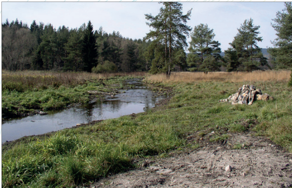
Obr. 145b. Na sedimentační tůň na Zbytinském potoce navazující volný rozliv do vysokostébelné nivy s chřasticí a tužebníkem. Tůň zachycovala písek a rozliv naopak část jemných jílových částic. Sediment z tůně musel být opakovaně odstraňován pomocí bagru.
