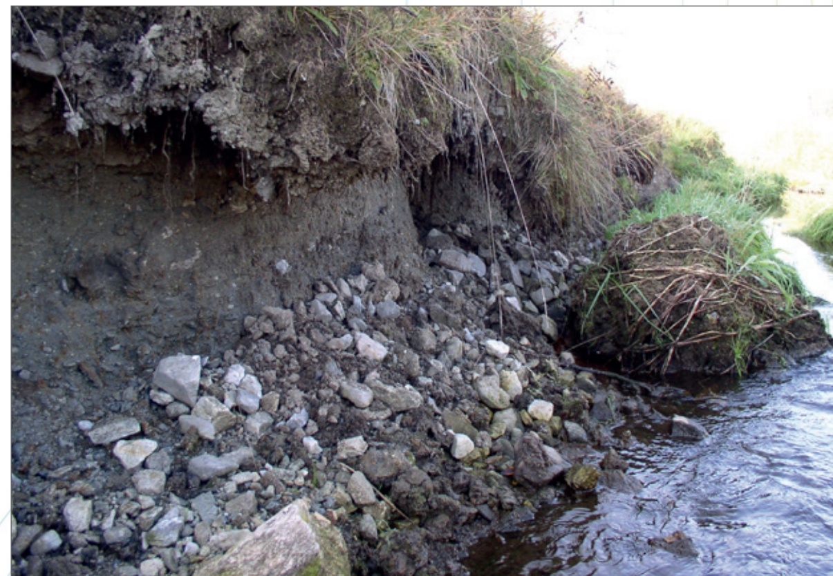
Obr. 150a. Zpevnění erodujícího koryta haťošterkovým válcem. Erodující koryto Blanice.
