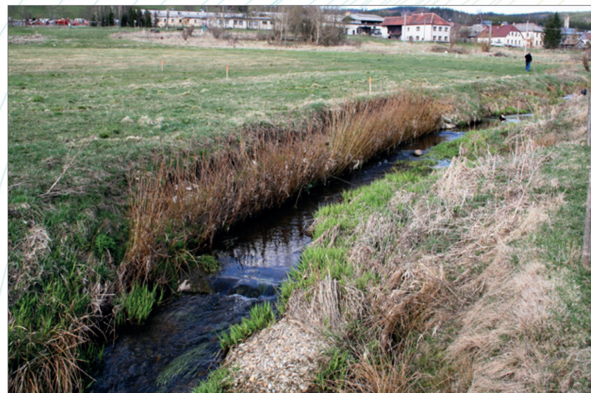
Obr. 150b. Obrstlý haťošterkový válec po první vegetační sezóně ve Zbytinách (podrobněji viz Příloha 23).
