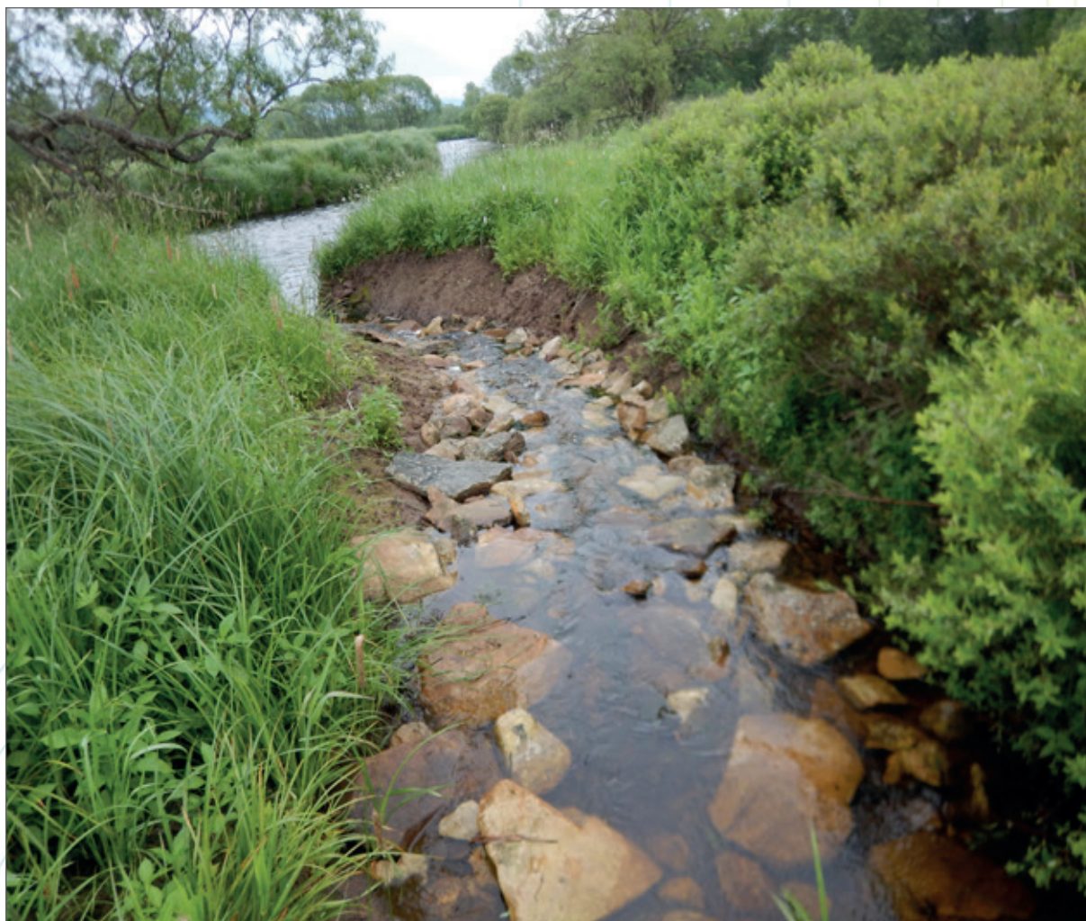
Obr. 136. Strmé ústí Žlebského potoka do Teplé Vltavy. Koryto zde bylo vymodelováno a zpevněno kameny, na rozdíl od ploché nivy, kde byl vodě ponechán prostor pro samovolné dotváření koryta.
