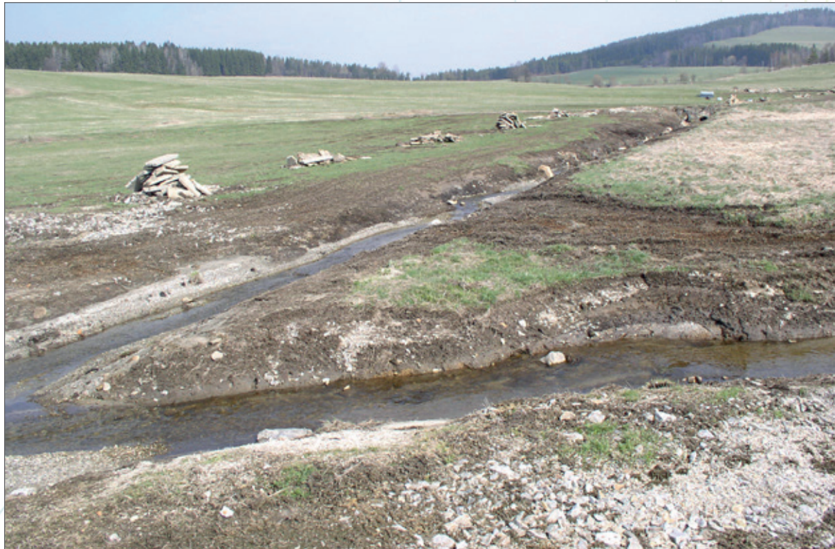
Obr. 134a. Revitalizace části Zbytinského potoka a Sviňovické strouhy. Zbytinský potok a Sviňovická strouha (ústí) bezprostředně po revitalizaci. Vedle koryta jsou patrné zbytky vytrhaného betonového opevnění, tok zůstal zahlouben a napřímen.
