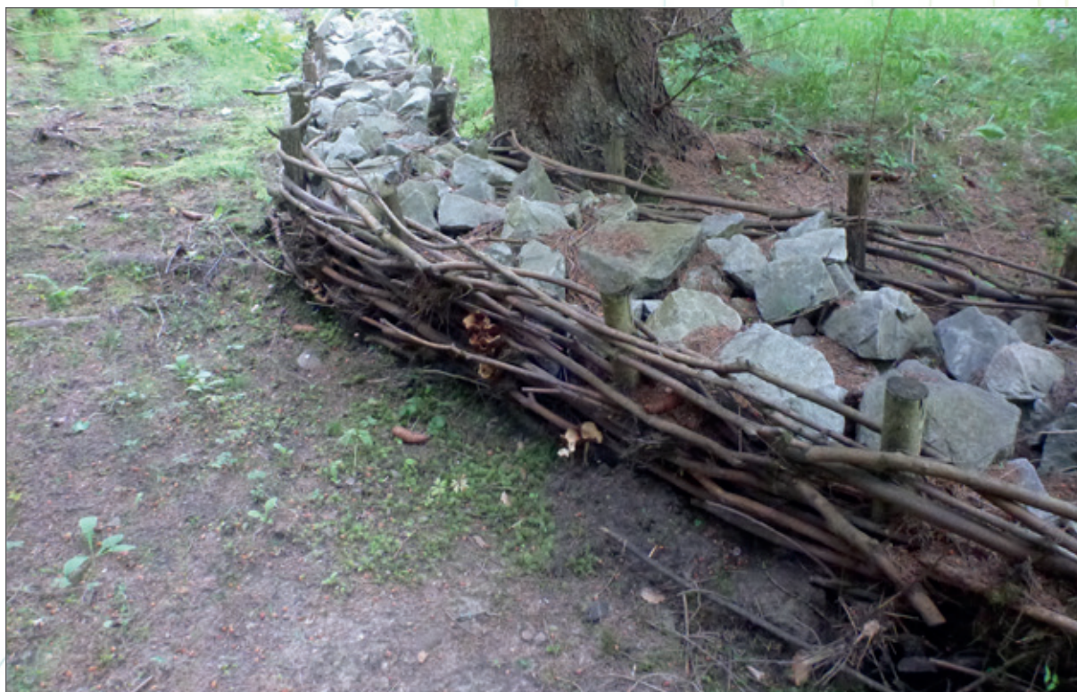
Obr. 143. Hrázka tvořená dvojitým vrbovým oplůtkem a vyplněná uvnitř lomovým kamenem. Při vyšších vodních stavech voda částečně hrázku obtéká, částečně protéká skrz. Jemnozrné i hrubozrné plaveniny se zachytávají před hrázkou.
