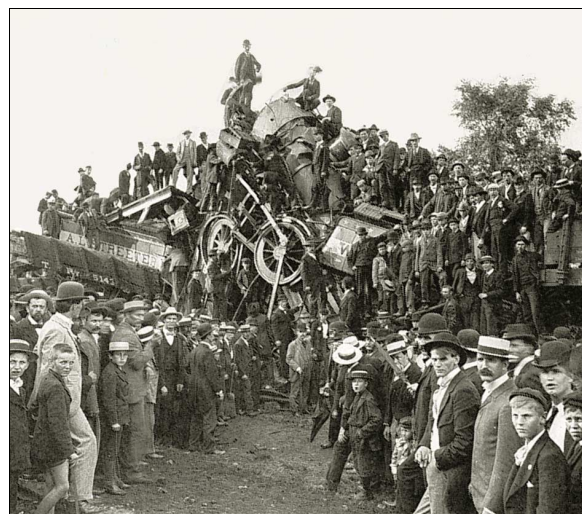
Obr. 7.1 Příklad 7.1. Následky srážky lokomotiv v roce 1896
