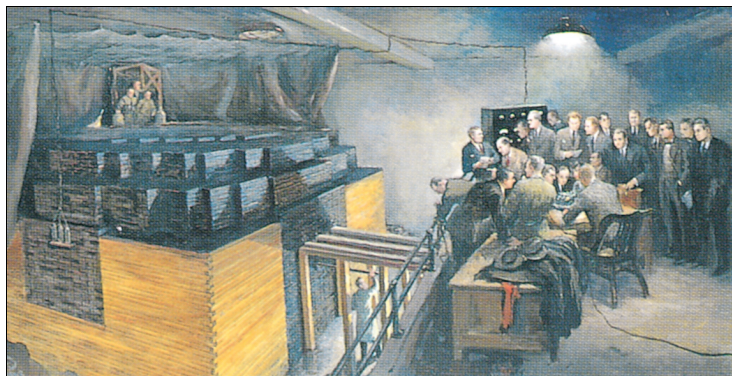
Obr. 44.8 Obraz prvního jaderného reaktoru, který postavila během 2. světové války na hřišti pro squash University of Chicago skupina, vedená Enrico Fermim. Tento reaktor začal pracovat v kritickém režimu 2. prosince 1942; byl sestaven z uranových hrudek zabudovaných do grafitových cihel. Posloužil jako prototyp pro konstrukci dalších reaktorů, které měly vyrábět plutonium pro jaderné zbraně.
