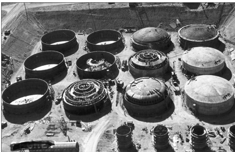
Obr. 44.7 Fotografie výstavby podzemního úložiště cisteren v Hanford Site ve státě Washington během 2. světové války. Všimněte si nákladních aut a dělníků. Každá z velkých cisteren pojme téměř 1 000 m 3 vysoce radioaktivního tekutého odpadu.
